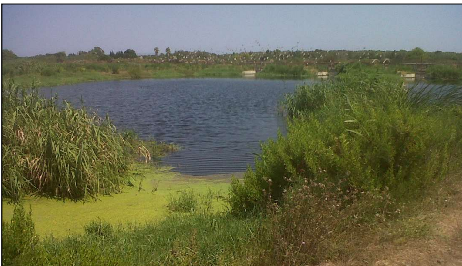
Fitodepuratore di Melendugno (LE)
